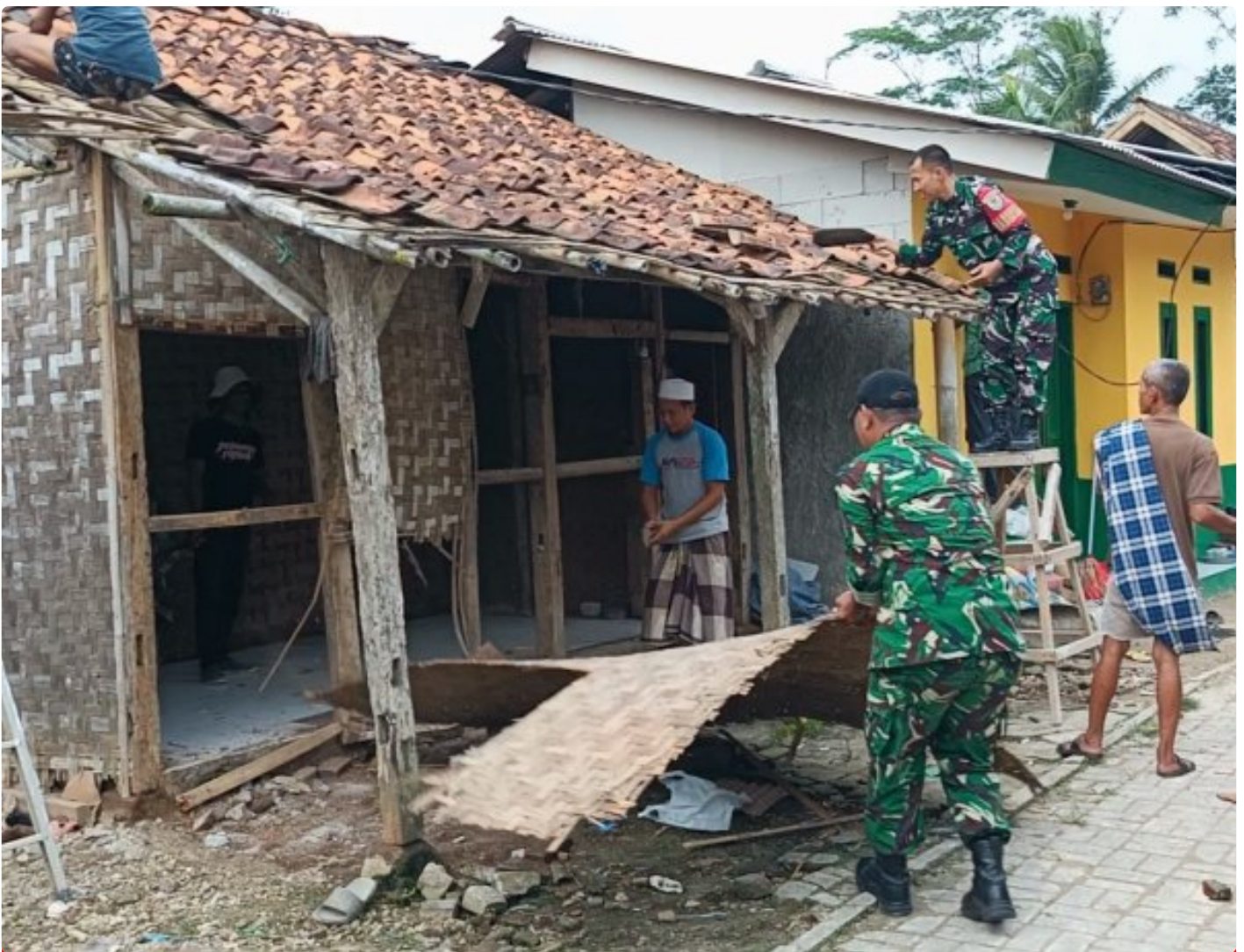
Pembongkaran Rumah Bapak Narmin
